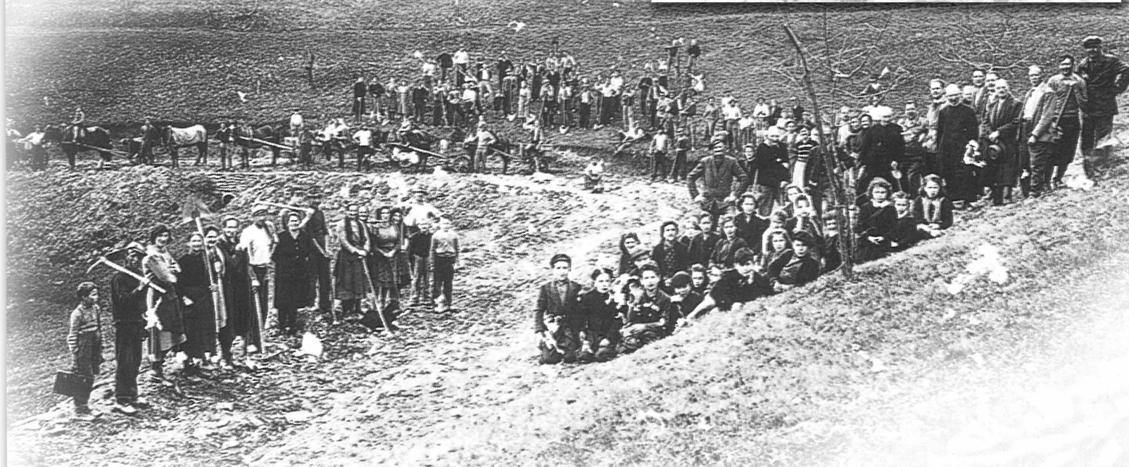
Volontari al lavoro per la costruzione della strada
